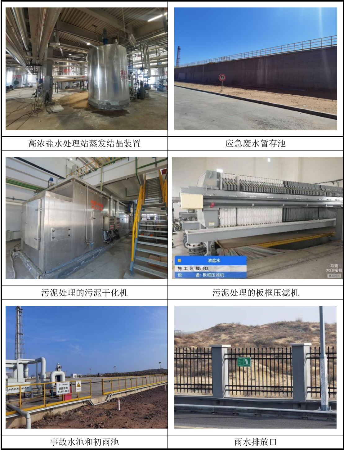
图 3.2-5 现有工程废水污染防治措施图
