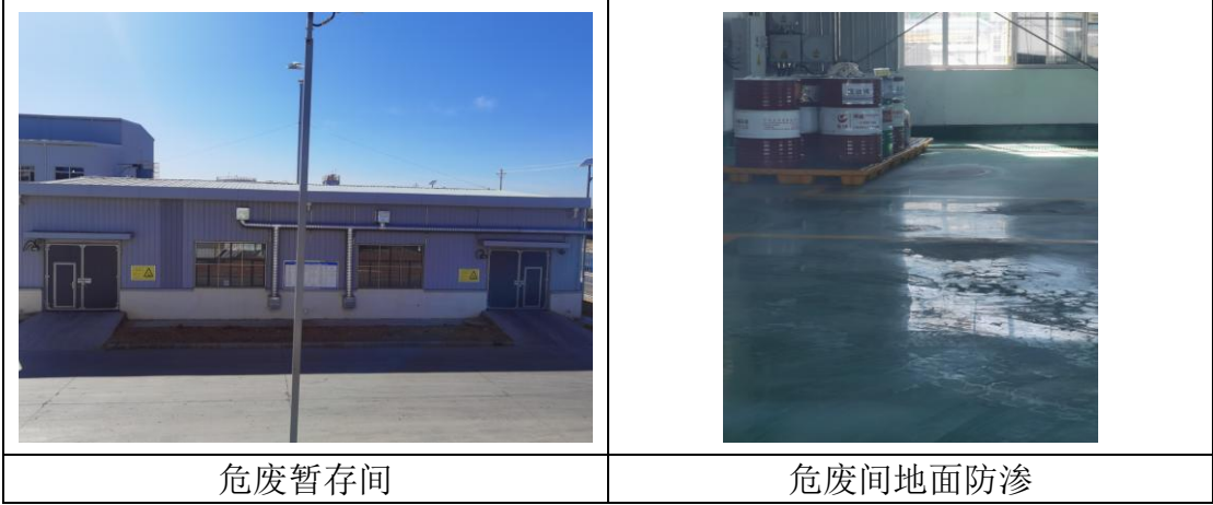
图 7.5-1 危废暂存间现场情况图
